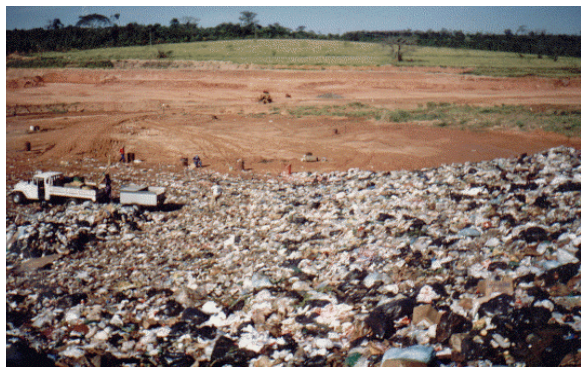
Figura 01- Aterro Sanitário de Bauru. Depósito diário de 300 toneladas de lixo.
