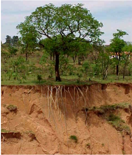
Figura 01- Erosão na nascente do Córrego Água do Sobrado.
