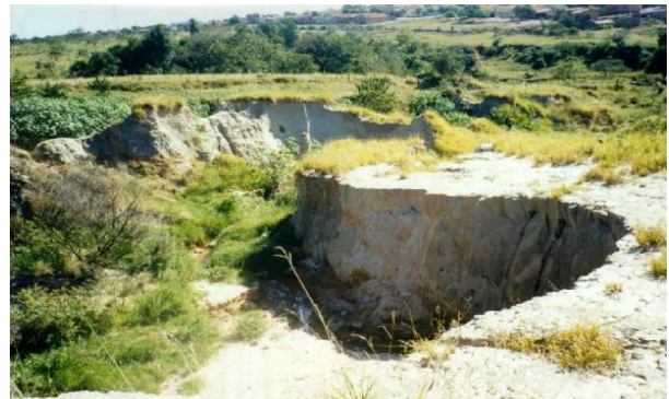
Figura 08- Pousada da Esperança II: o impacto degradante ambiental provocado pela boçoroca.
