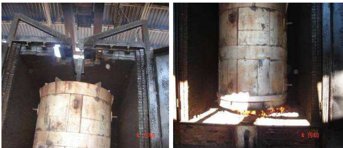
FIGURA 2 – Sistema de carbonização em fornos cilíndricos verticais
